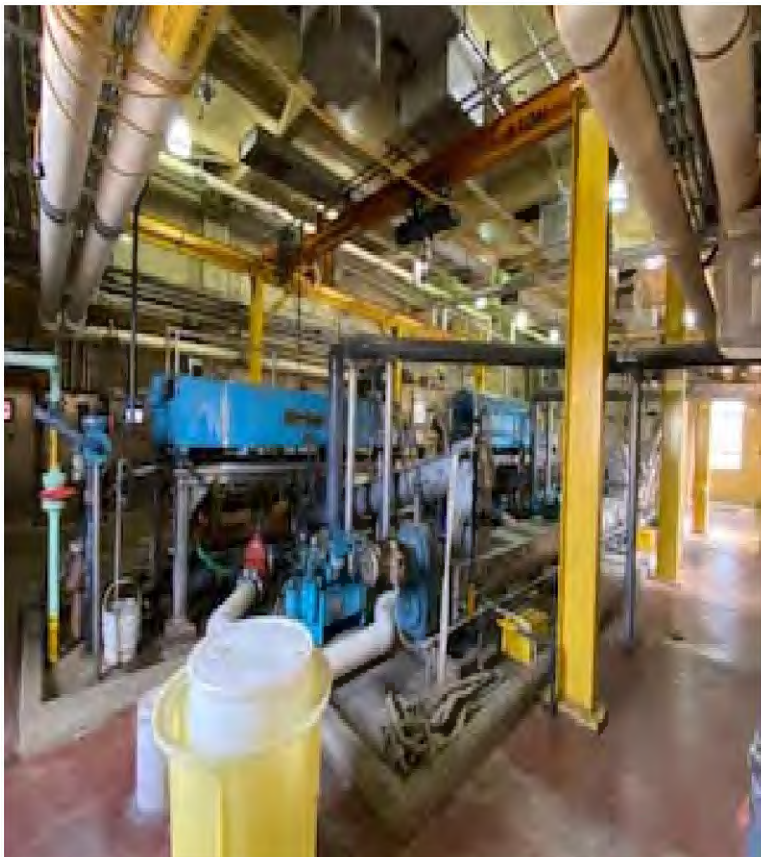
Sludge Centrifuge
